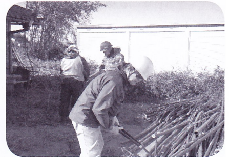
枝木の搬出作業
