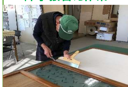
障子張替え作業
